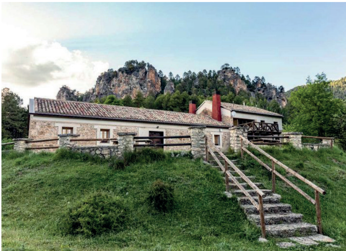
Vista general del Albergue de Tejadillos
