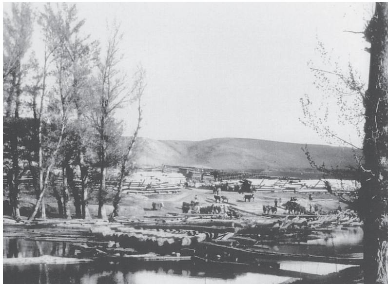
Desembarcadero del Sargal a principios del siglo XX. Se observan las caballerías y los arrastradores y sus caballerías junto a las grandes cambras de maderarcadas
